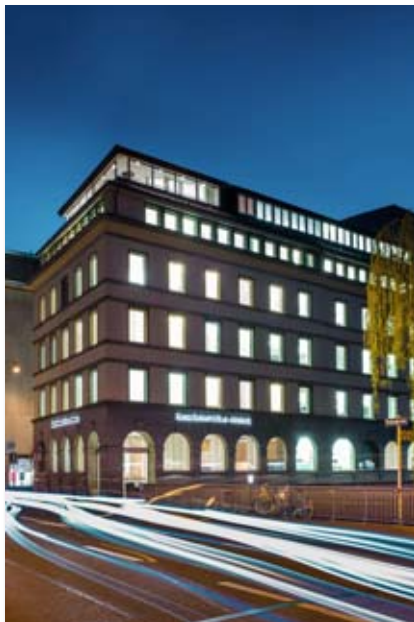
Der Sitz von Maerki Baumann & Co. AG in Zürich
